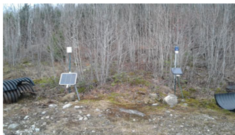
Capteurs d'incendie. Photo : Gouvernement du Canada
